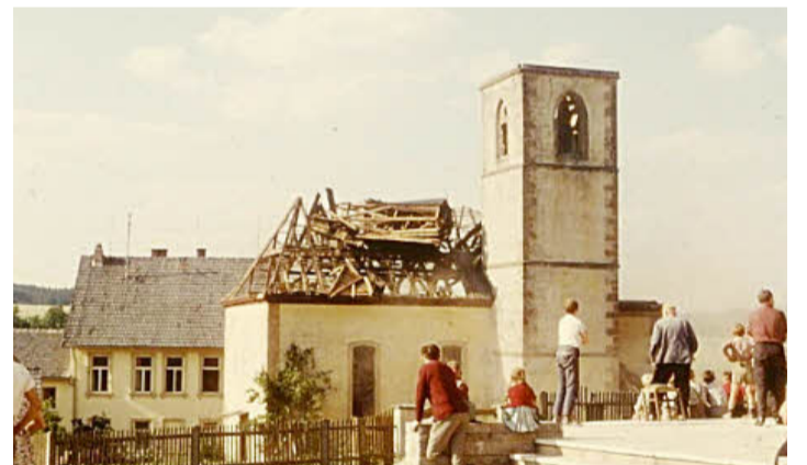
1964 wurde die alte, einsturzgefährdete Kirche abgerissen
